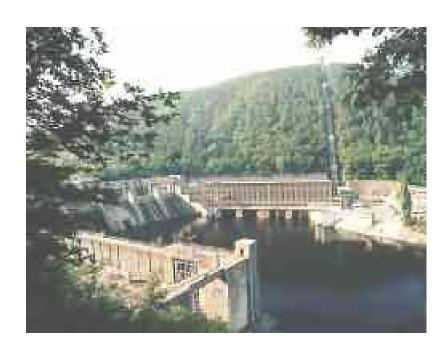
• Die Talsperre wurde während des 2. Weltkriegs gebaut. Der Damm ist 124 m lang, 22 m hoch. Der See ist 9,4 km lang. Von hier aus regelt man die Arbeit in allen Kraftwerken an der Moldau.
